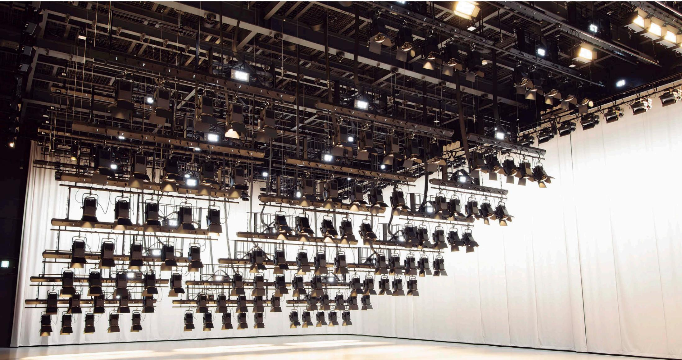
MBS ライブセンタースタジオ 48 掛の双方向通信制御システムを備えたバトンにより、各 LED 照明器具①②③他の固定アドレス自動割り付けシステムを実現。
