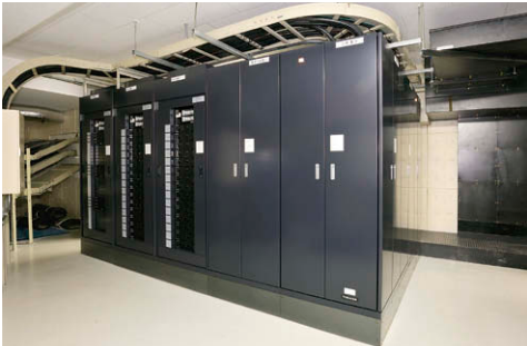
主幹盤・調光器盤「PLUG-IN DIMSTARⅢ」 ③
