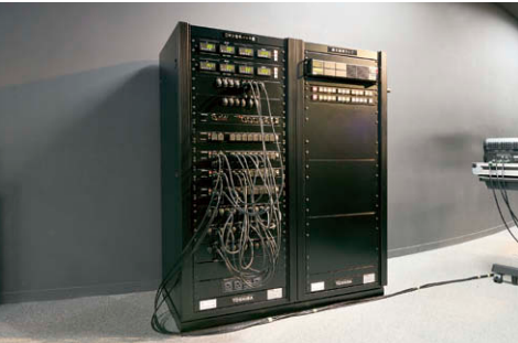
DMX 信号パッチ盤と調光制御ラック盤。 ④⑤
