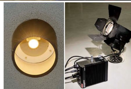
(左) 既設照明器具に⑧ LEDシアターシリーズ電球システム(ハロゲン電球形)を設置 (右) ⑥可搬形調光器ポータブルディムスターⅢで持ち込みハロゲン器具に対応。
