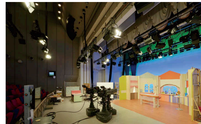
ステージ(スタジオ)部分 ①② LEDスポットライト、③ LEDブロードライト、④⑤ LED水平ライトを備え、通常のテレビスタジオとして機能。
