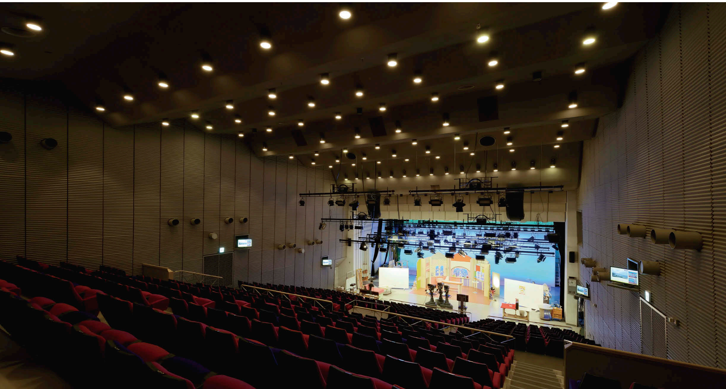
客席からステージを望む 客席照明は既設器具と配線を活かして⑧ LEDシアターシリーズ電球システムを採用し、ちらつきのない、0～100%のなめらかな調光を実現。
