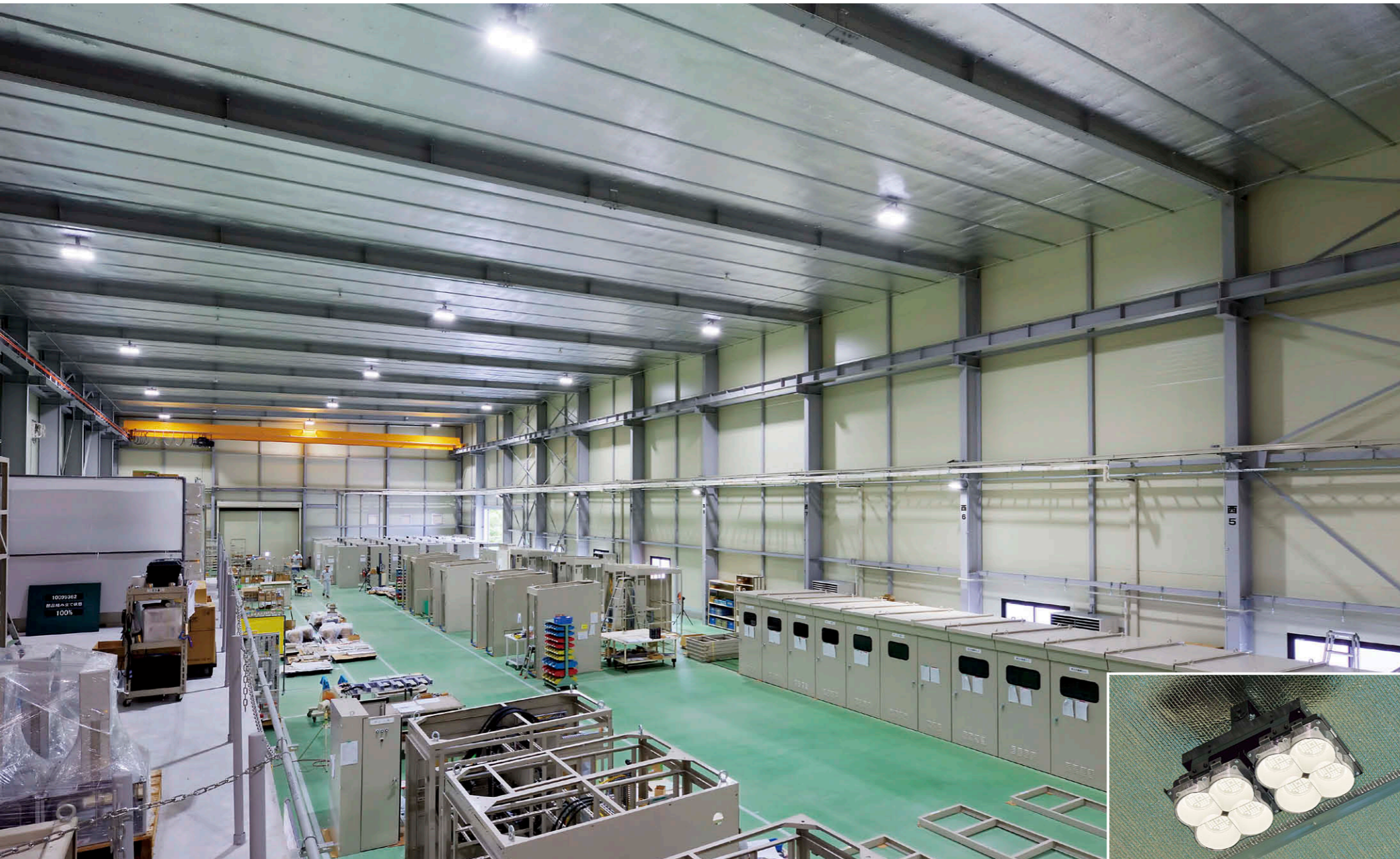
工場棟工場部 光色4000K、光束44,400lmのLED高天井器具①18台を、天井熱反射シートの内側でボルト吊りにて取り付け、明るい作業環境を創出。(右下は器具アップ)
