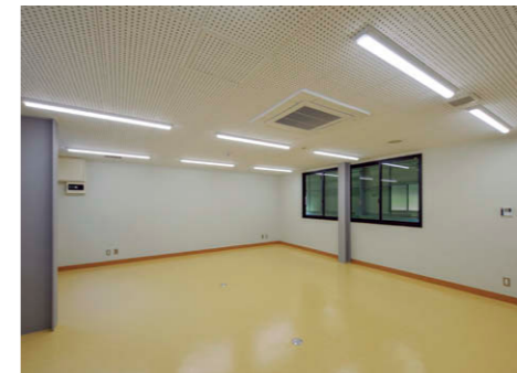
工場棟事務室 5,200lmタイプの直付形LEDベースライト②を採用し明るさを確保。
