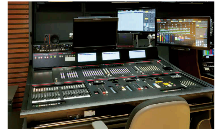
調光操作卓 S2 スタジオと共通仕様とした調光操作卓⑧。RDM の双方向通信により LED 照明器具の吊り位置情報などの認識を可能とした。
