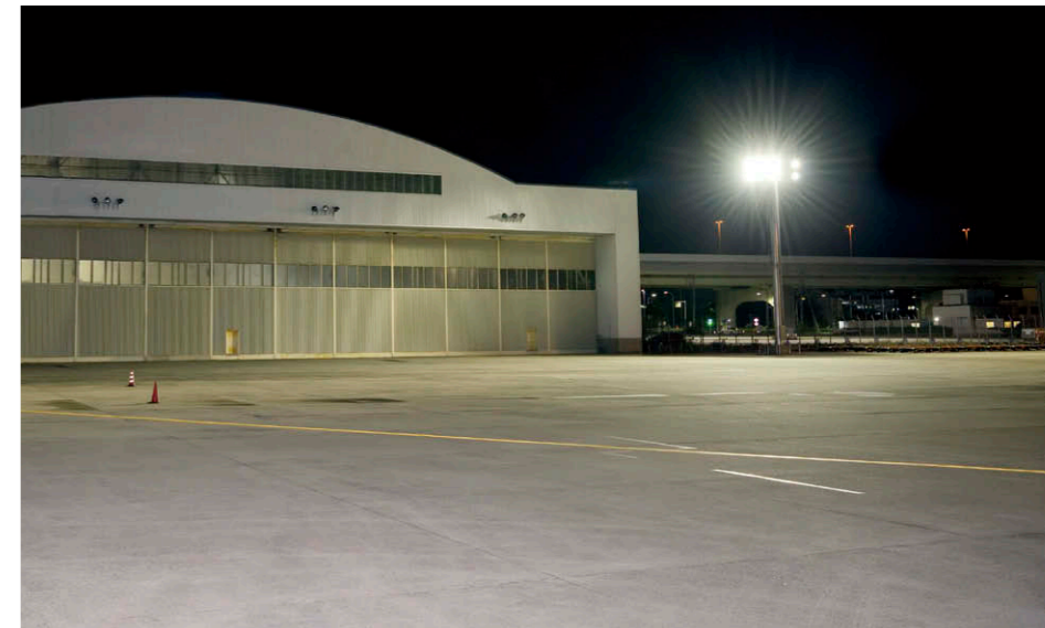
格納庫前 作業環境に適した5000Kの明かりが格納庫前のエプロンを照らす。
