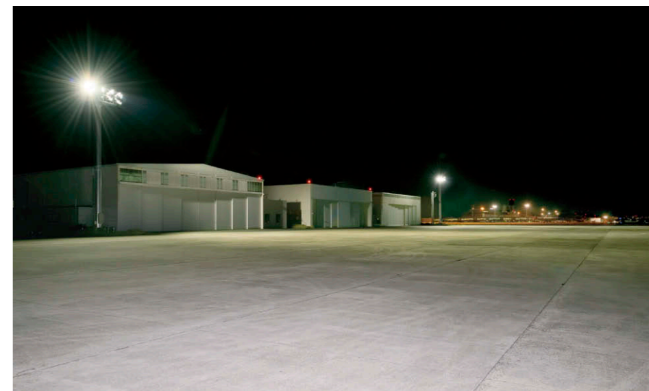
格納庫前 写真奥側エプロン中央エリアのナトリウムランプ色と対照的な手前側昼白色の照明環境。
