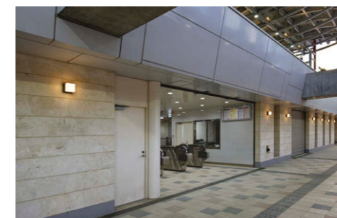
ピロティ 琉球石灰岩や花ブロックを用いた地域色ある外壁に合わせてLEDブラケット⑥を採用。
