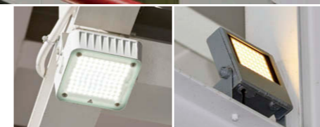
天井の梁に設置されたベース照明器具(左)と LED小形角形投光器(右)
