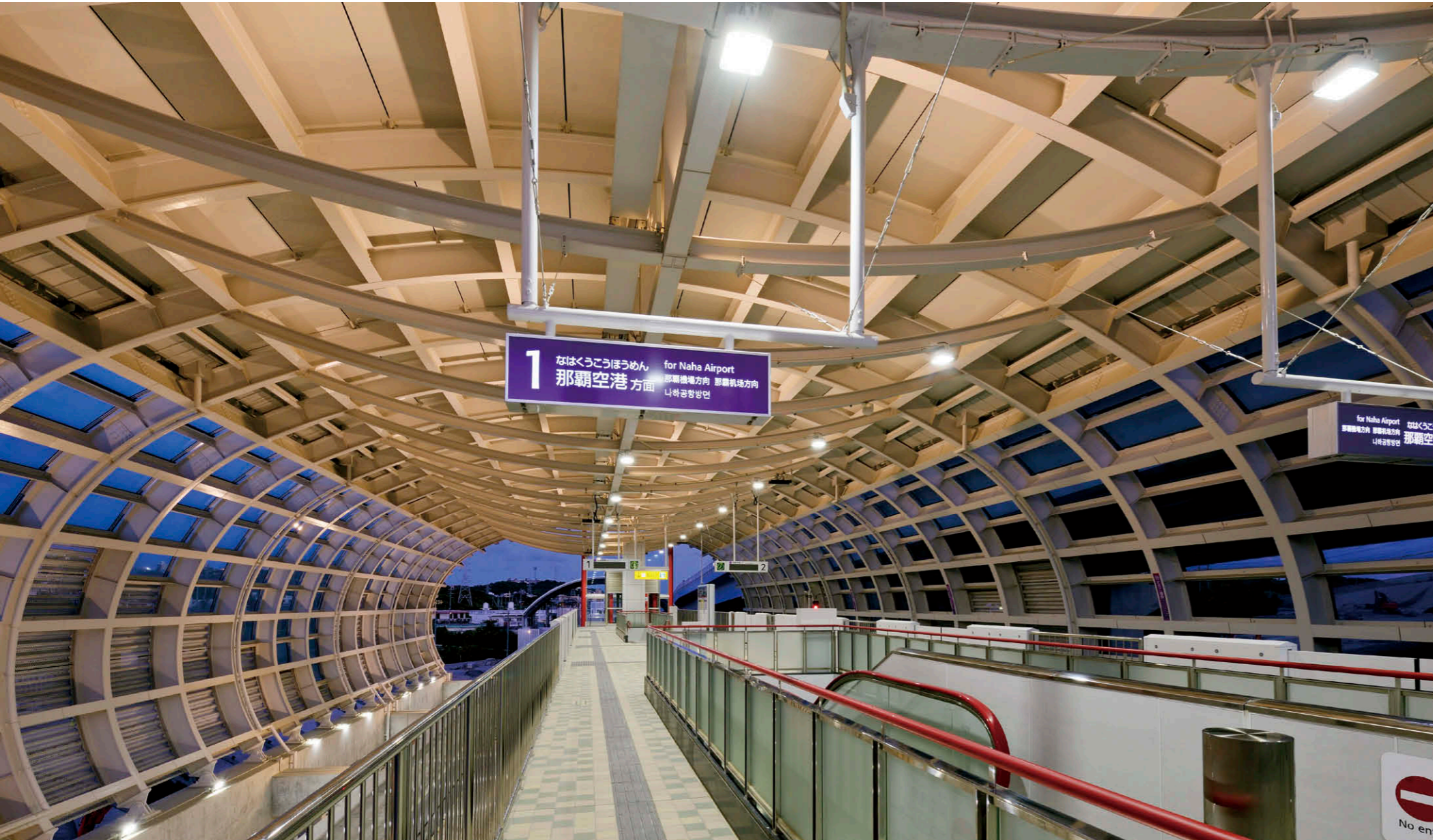
大屋根ライトアップおよびプラットフォームの照明 ベース照明のLED高天井器具①は昼白色、ライトアップ照明のLED小形角形投光器②は電球色と、照明演出の目的に合わせて光色を選択。
