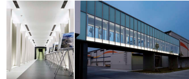
工場棟/ホール 自然光を取り入れるトップライトを中央に設け、11灯連結のLEDベースライト⑨を左右に配置。 工場棟/工作室 LED高天井器具⑦8台とレースウェイに設けたLEDベースライト⑧が影を抑えた作業環境を創出。
