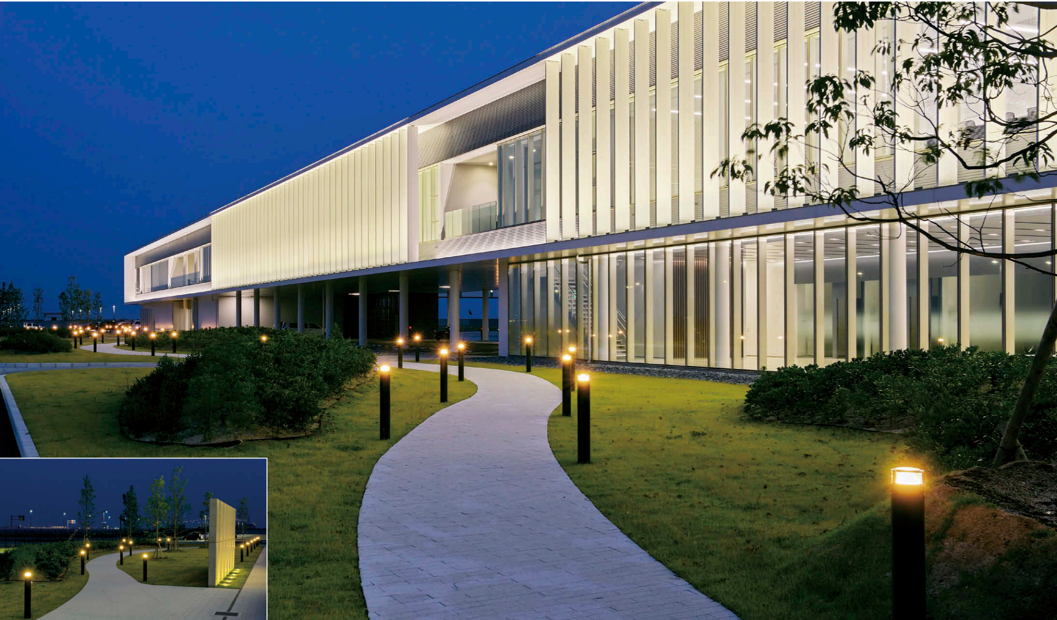
事務棟ライトアップおよび外構の照明 150Wコンパクトメタルハライドランプ器具相当のLED小形角形投光器①とLEDライン器具屋外防水用ライン器具②により事務棟2階をライトアップ。外構緑地には2700KのLEDガーデンライト③を計60台採用。
