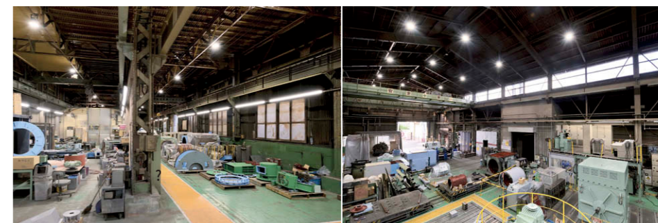
第1工場内 (左) LED ベースライト④を直線的に配置して明るい手元作業環境を創出。(右) LED 高天井器具①②を多用し、その内の3台の器具を万が一に備えて自家発電回路に接続。
