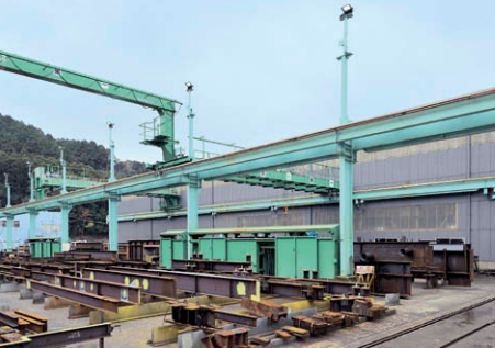
C・Dヤード 奥側A・B棟の外壁面とC・D境界部に設置したLED小形投光器③
