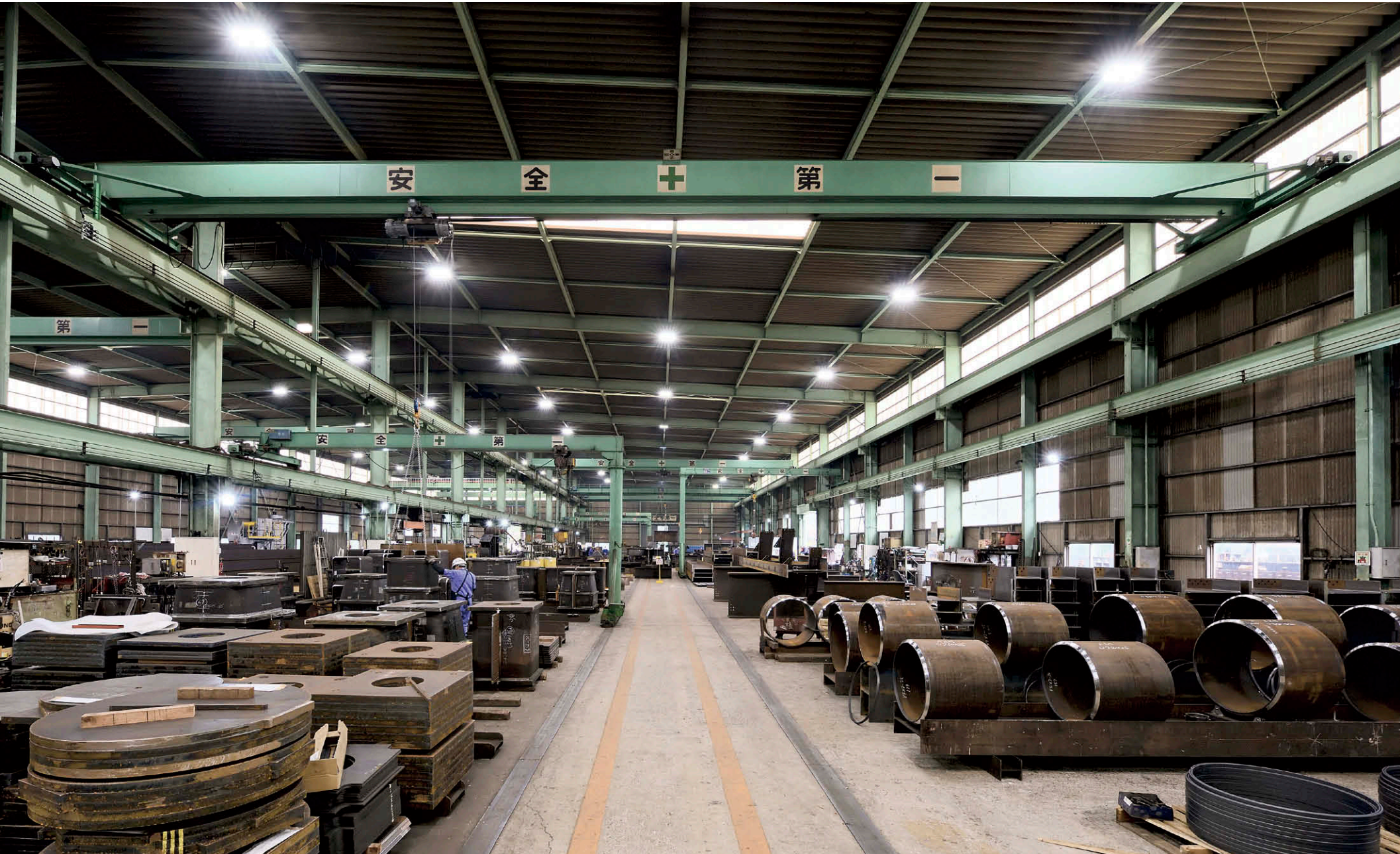
A・B棟の照明 奥行き100mを超える空間にLED高天井器具①を計70台配置。さらに壁面には昼光色6500KのLEDフラッドライト②を設置し明るさを補完。
