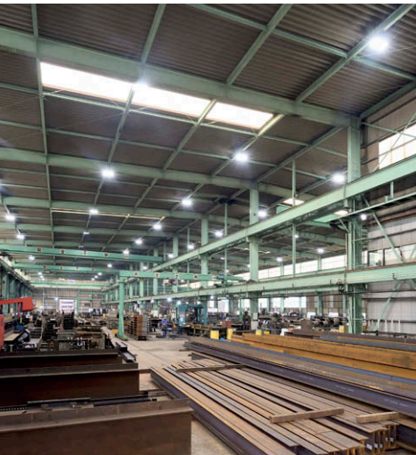
B棟側 空間の隅々まで5000Kの光を行き渡らせる112度の配光角のLED高天井器具①
