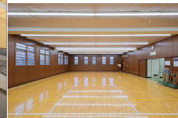
LED高天井器具軽量タイプ①②③ 既設FLR110形器具からTENQOO110タイプW230⑤に更新の剣道場。消灯時(上)と点灯時(下)。
