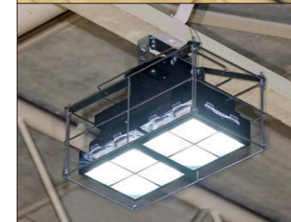
LED高天井器具軽量タイプ①②③ 既設FLR110形器具からTENQOO110タイプW230⑤に更新の剣道場。消灯時(上)と点灯時(下)。
