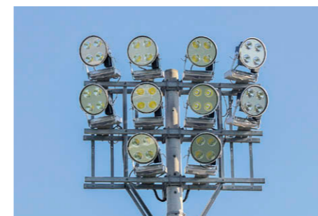
①②LED投光器 照明塔に10台設置
