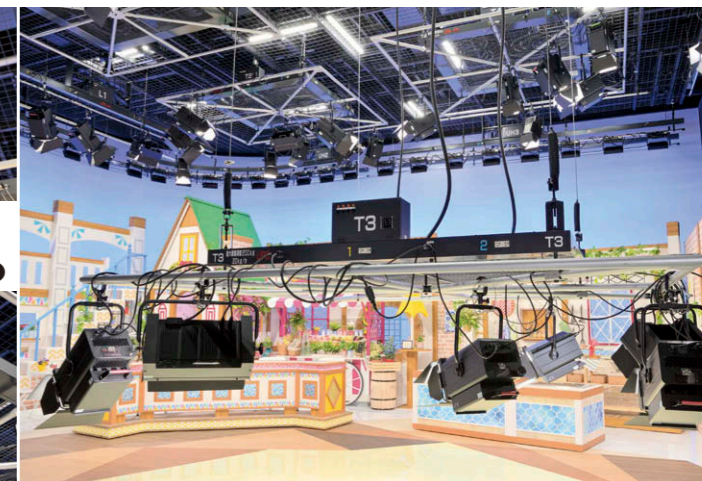
トラスバトン トラスバトンにより昇降装置の台数を減らしてコストを削減。LED スポットライト①②、LED ブロードライト③の器具情報は RDM 双方向通信により自動認識。
