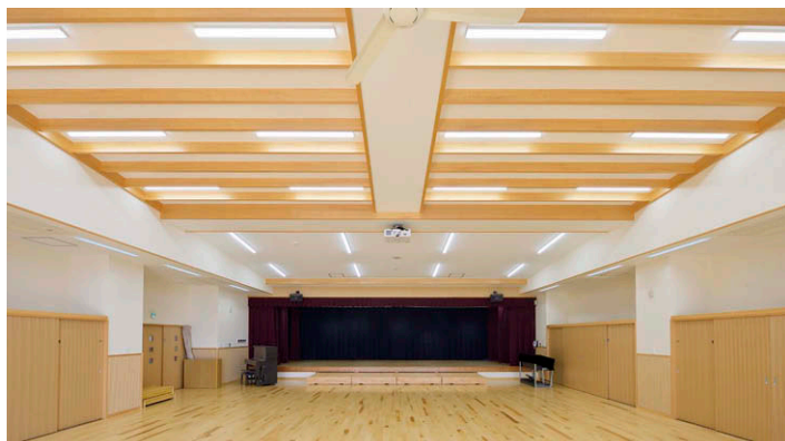
遊戯室 勾配天井の開放的な空間が広がる遊戯室はLEDベースライト埋込形(アルミルーバー付)①②とLEDベースライト直付形③で500ルクスを確保。
