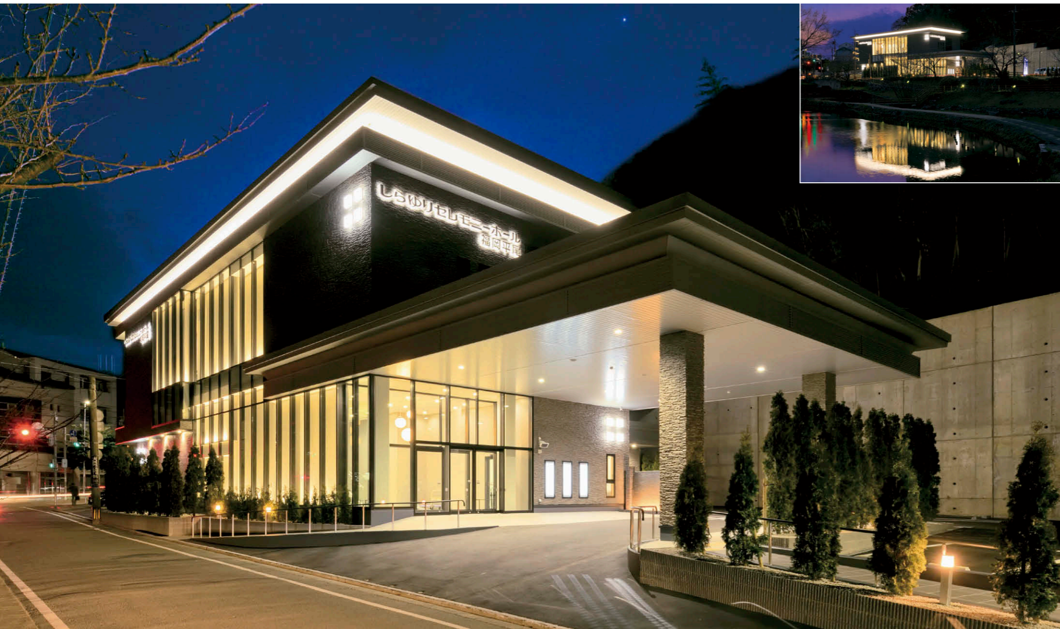
外観のライトアップ風景 北面を除く屋根の底下に5000Kの防雨形LEDライン器具①を間接照明として配置し、薄暮から夜間のライトアップを実施。
