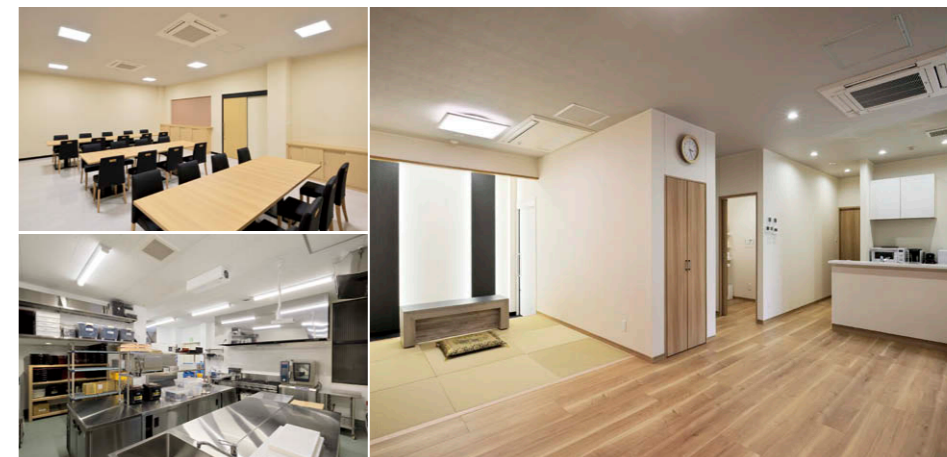
(左上)1階会食室 調光可能なLED一体形スクエア器具⑥を6台配置。/ (左下)厨房 ステンレス白色タイプの防湿・防雨形器具を採用。/ (右)2階控室 「アーバンホテル」をコンセプトに落ち着いてくつろげる空間をLED一体形ダウンライト⑧をはじめとする住宅照明器具により創出。
