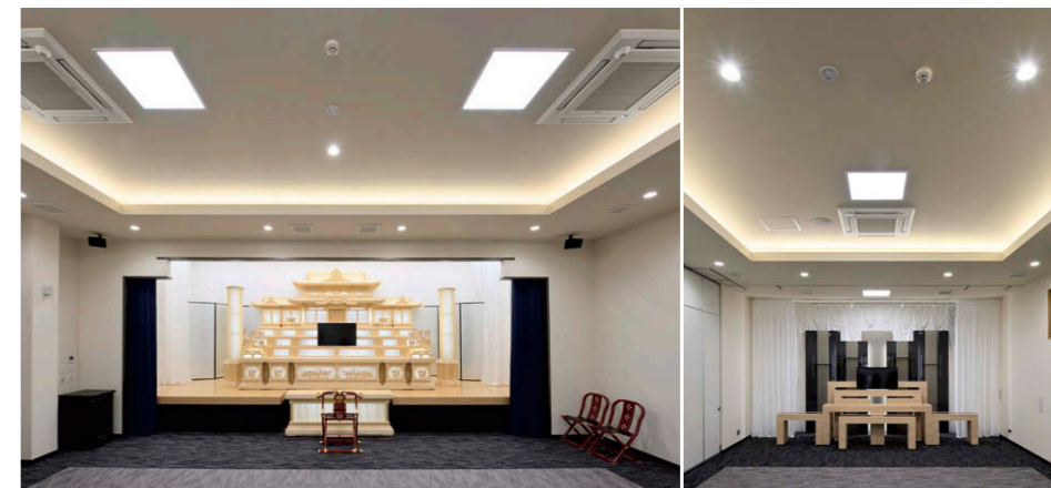
(左)斎場/ (右)小斎場 照明演出が可能な5000Kの調光器具を採用。ベース照明にはLEDダウンライト⑤とLED一体形スクエア器具⑥を配置。折り上げ天井にはTENQOOシリーズ直付形④によるコーブ照明を実現。
