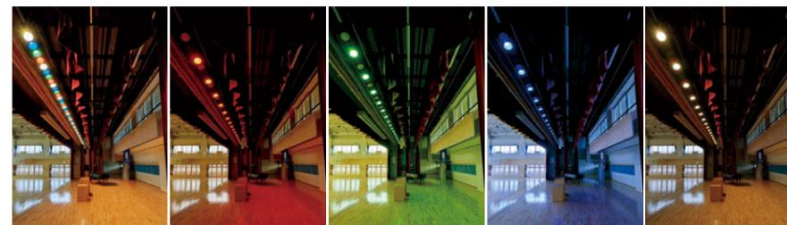
体育館舞台照明 4回路タイプの12灯LEDボーダーライト②③を計6台連結設置。18チャンネルタイプのフェーダボックスDMX制御により、式典や文化イベントなどで幅広い照明演出を実現。
