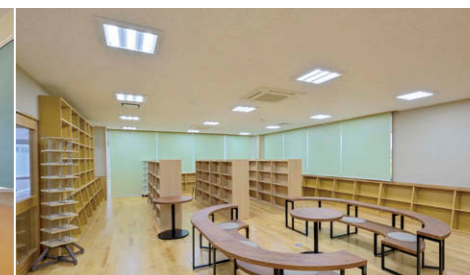
図書室 6,850lmのTENQOOスクエアLEDバータイプ直付埋込兼用形④18台を分散配置。
