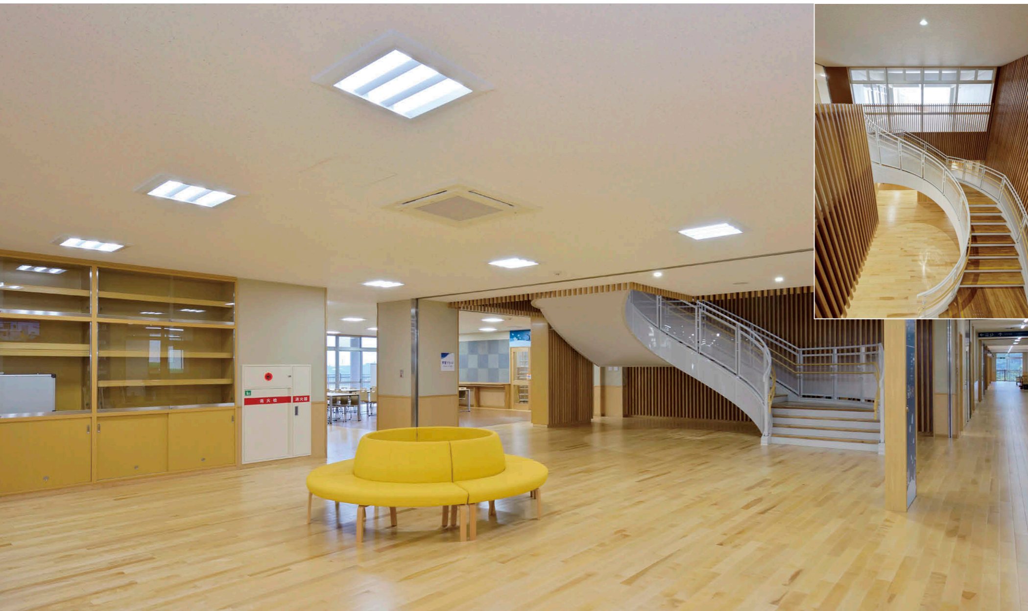
2階エントランスの照明風景 FHP32形×3灯用省電力タイプのTENQOOスクエアLEDバータイプ直付埋込兼用形①16台を分散配置し、明るい照明環境を創出。
