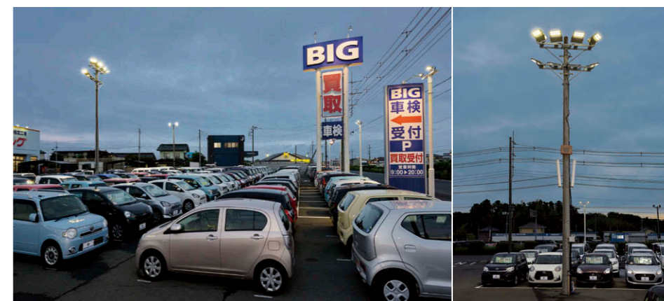
国道入口付近から見たLED投光器①②③による照明。
