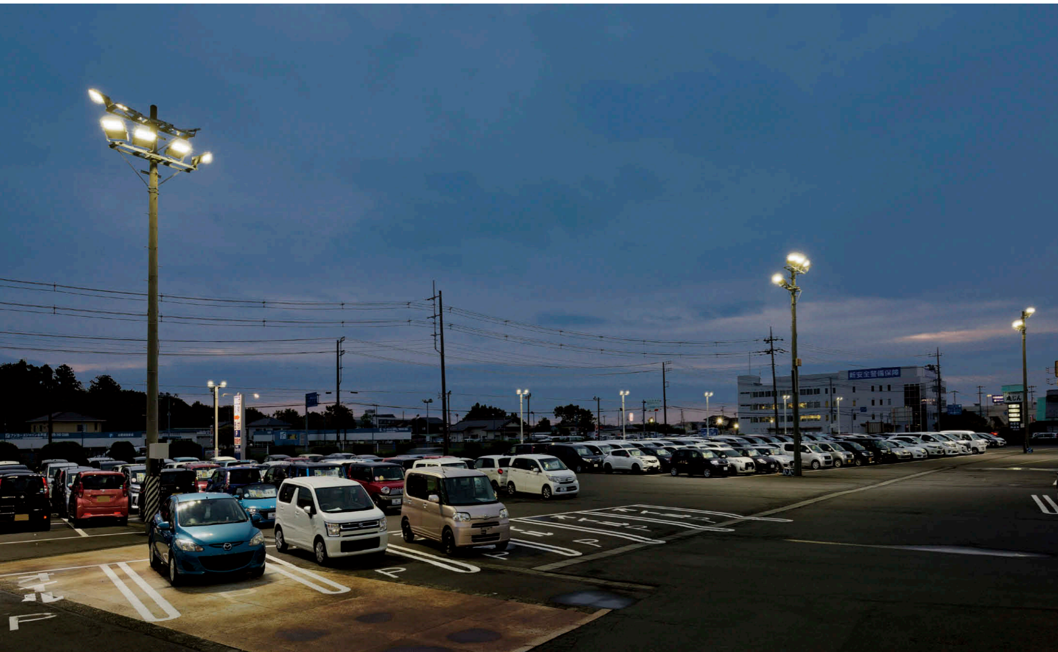
オフィス棟サイドから望むLED投光器①②③による照明。
