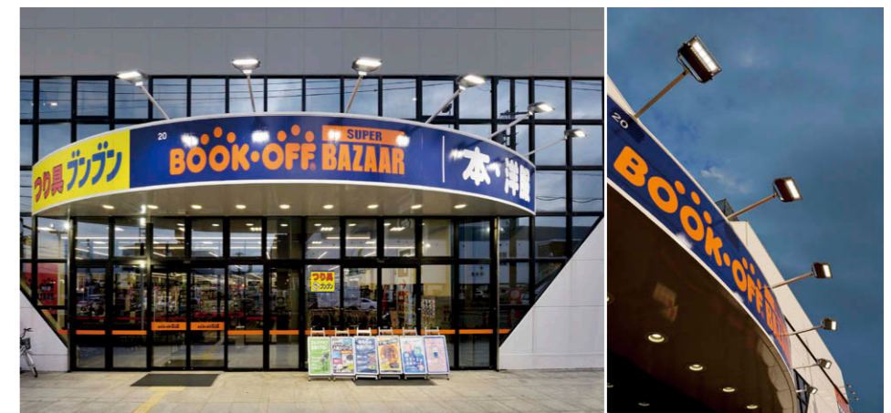
平均照度2000ルクスの明るさのファサードの照明。
