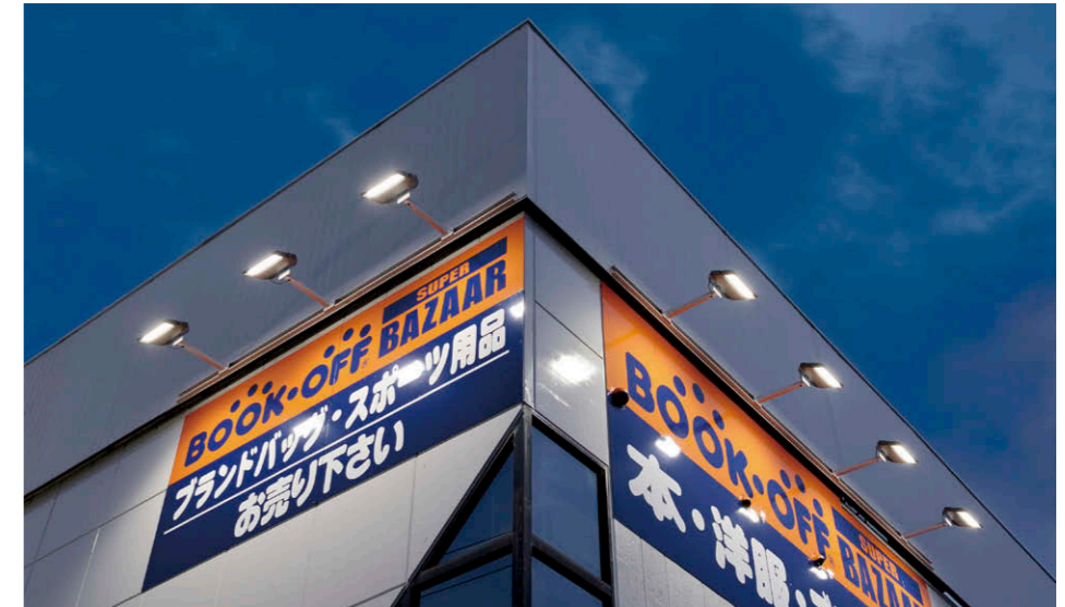
7台のLED角形投光器①に照らされた右サイドのパネル看板照明。
