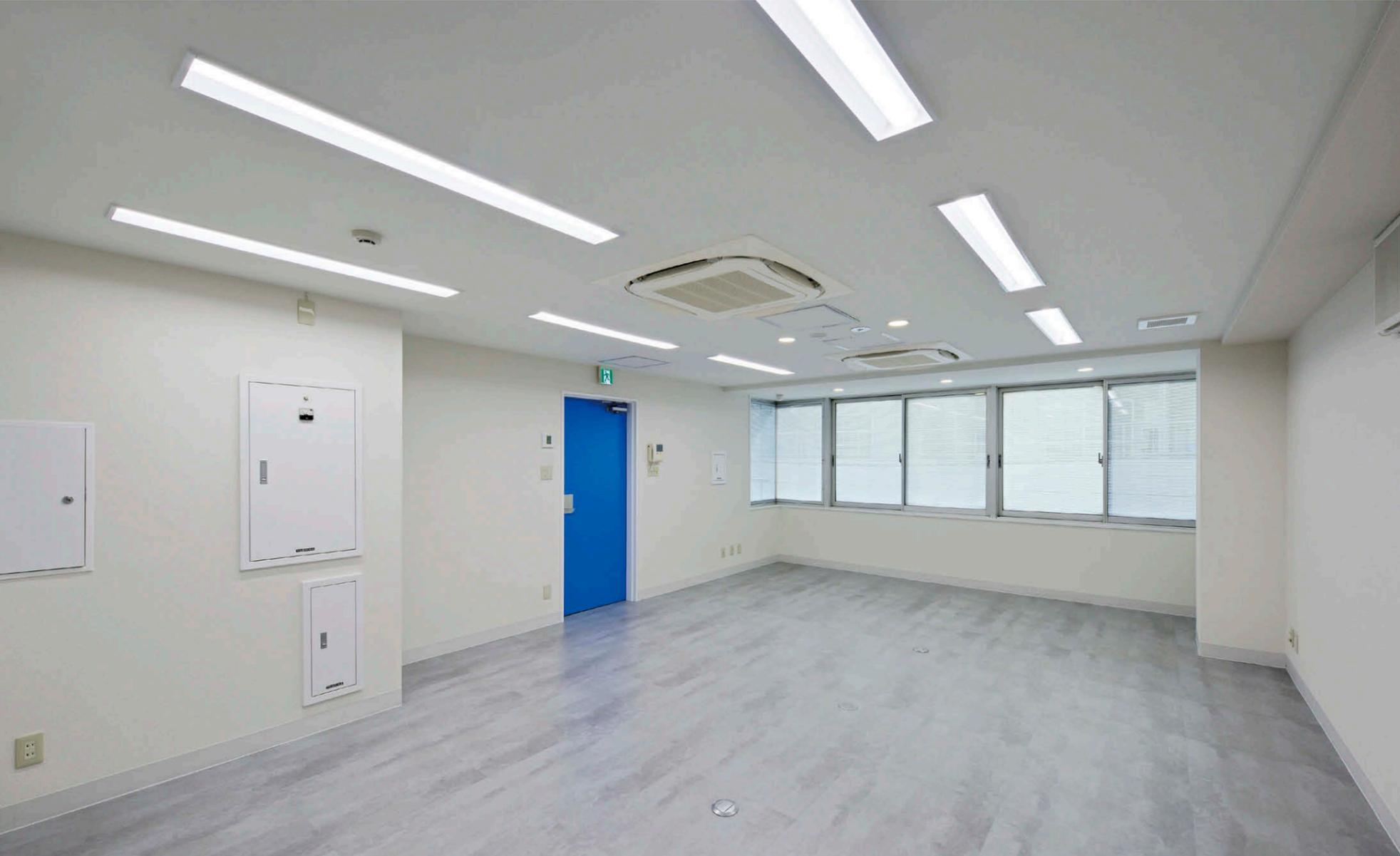
3階オフィスフロア LEDベースライトTENQOOシリーズ 埋込形①とLEDユニット交換形ダウンライト②を配置。
