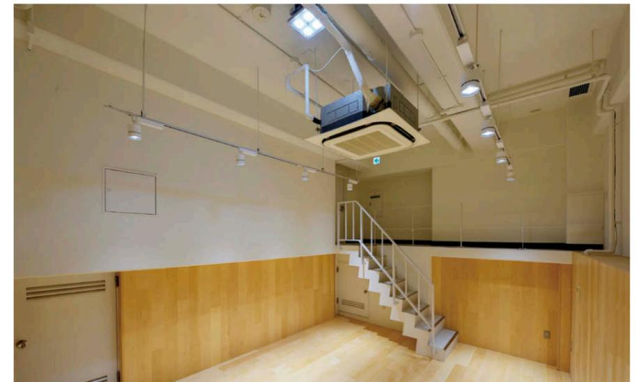
地下の多目的ホール LED高天井器具スタンダードタイプ調光形⑥とLEDスポットライト⑦を設置。
