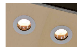
LEDシアターシリーズダウンライト②（大ホール音響反射板）
