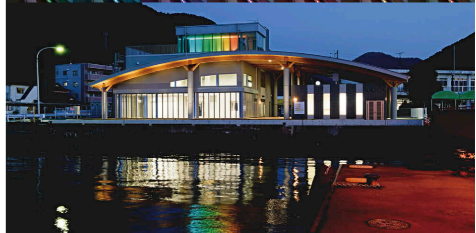
3階展望室のカラー演出と桟橋からの建物全景 光の混色の精度を高めた新技術IntelliHue採用のフルカラーLED照明③による展望室ライトアップ。
