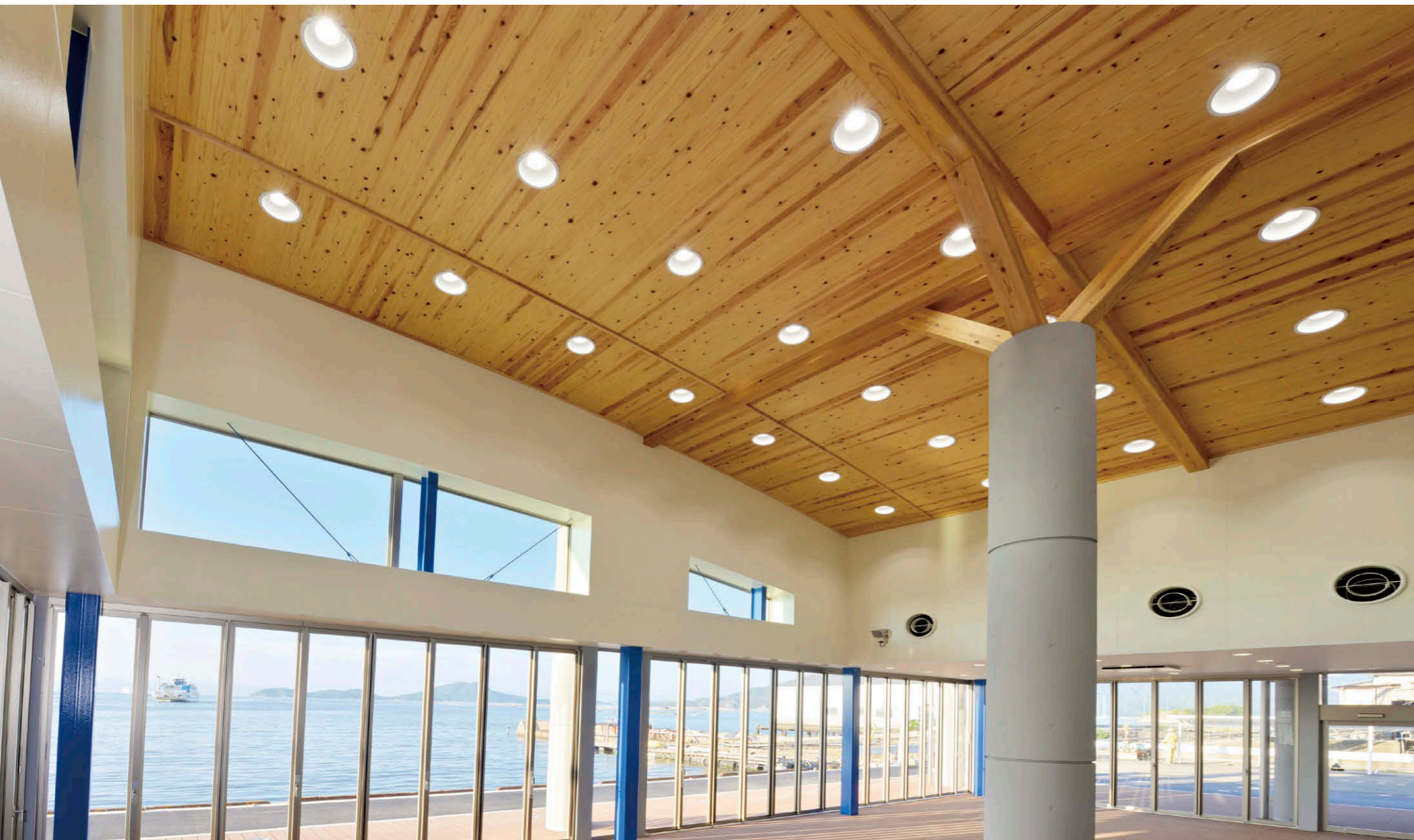
交流プラザ棟 1階みたか広場 大屋根天井に傾斜天井用プレートを使って配置した28台の軒下用LEDダウンライト①と、奥側天井に配置した20台のLEDダウンライト②より、賑わいを演出する明るい空間を創出。
