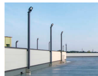
屋上駐車場 ポールを用いて配置したLED小形角形投光器⑦
