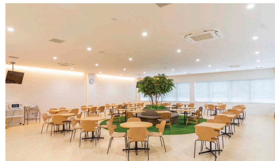
食堂 グループミーティングにも使用できる開放的な雰囲気の食堂には、ベース照明としてLEDダウンライト⑦を採用。屈曲面タイル貼りの壁面を電球色の間接照明で照らし柔らかな印象を演出。
