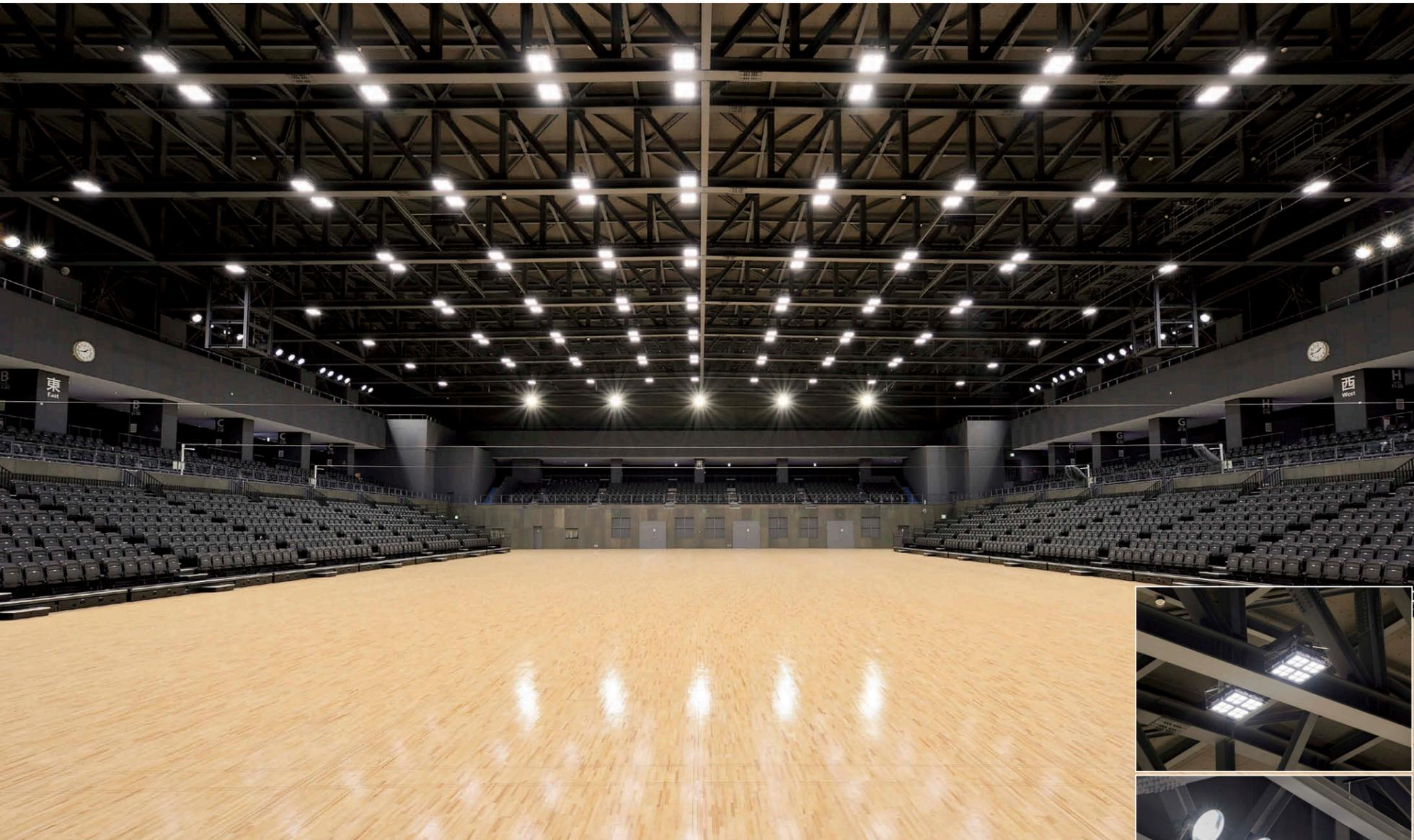
メインアリーナの照明風景 広さ約66×46m、天井梁高さ14mの大空間に、ハイパワータイプのLED高天井器具①計128台を2台1組で整列配置。
