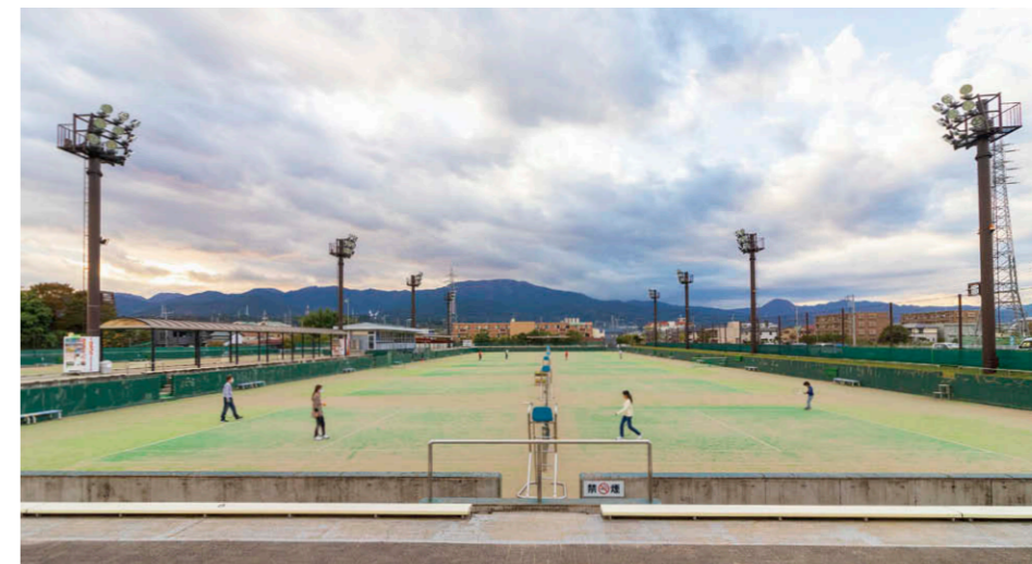
昼間のテニスコートの照明 8面のベースライン後方のコート間に照明柱4基を対面配置（合計8基）。
