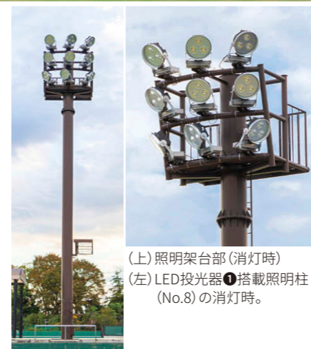
LED投光器①搭載照明柱（No.8）の点灯時。 ネット越しに見えるLED投光器によるナイター照明 コート8面の片面を照らす LED投光器①搭載の照明柱4基。
