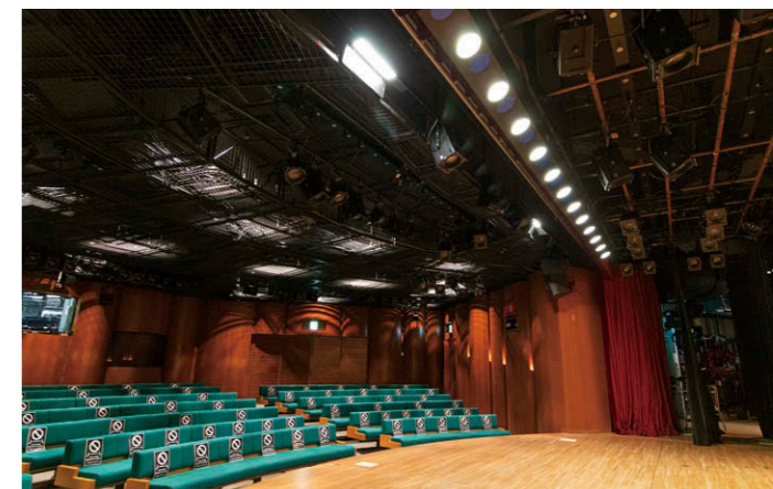
小ホール 小規模空間のため、客席照明にはLEDシアターシリーズダウンライト低天井向け②を配置。舞台にはLEDボーダーライト⑤を採用。
