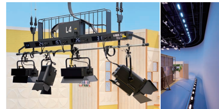
照明ボタン きめ細かなライティングが行えるようショートボタンを採用。LED スポットライト①②、LED ブロードライト③の器具情報を自動認識し、アドレスを液晶パネルに表示。
