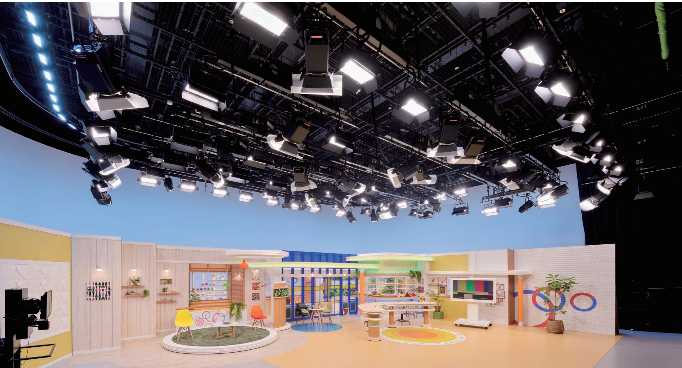
情報番組用セット LED スポットライト①②、LED ブロードライト③のセッティングが完了した状態。セット裏の水平ピットにはLED 水平ライト④⑤を配置。
