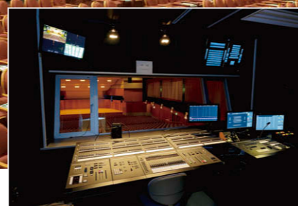
(上) 舞台照明に導入したLEDボーダーライト① (中) 音響反射板にはシアター用LEDダウンライト②を計54台採用。 (下) 多目的ホール用調光操作卓④
