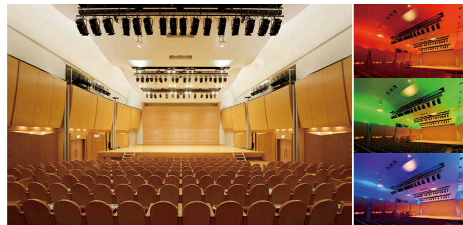
小ホール 舞台照明にLEDスポットライト⑥⑦⑧を採用。カラーLED⑤により舞台と客席を一体的に演出。
