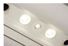
シアター用②1灯と高天井用③2灯のLEDダウンライトを1組とした多目的ホール天井照明。
