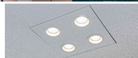
ダウンライト①は天井裏からメンテナンスができるように4台1組の着脱構造を採用。
