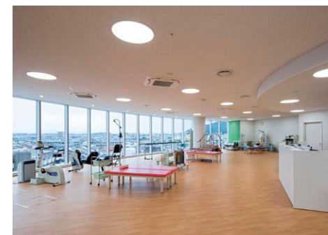
4階リハビリテーション科 清潔感を演出する5000KのLEDグレースベースライト⑥
