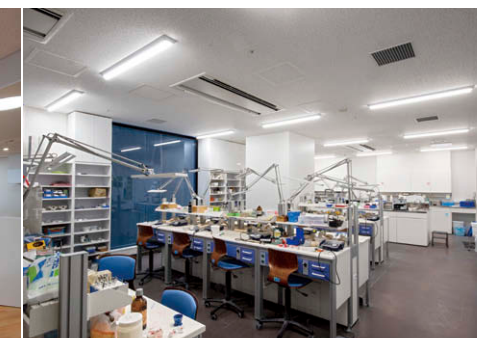
2階中央技工室 色の再現性が重視される歯科技工室には高演色タイプのLEDベースライト⑦を選択。
