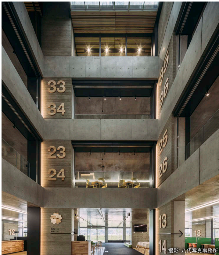
1階中央エコボイド 地域産杉材を利用したサインウォールを優しく照らす3000Kの間接照明。天井はLEDライン器具を直付けし落下物リスクを排除。
