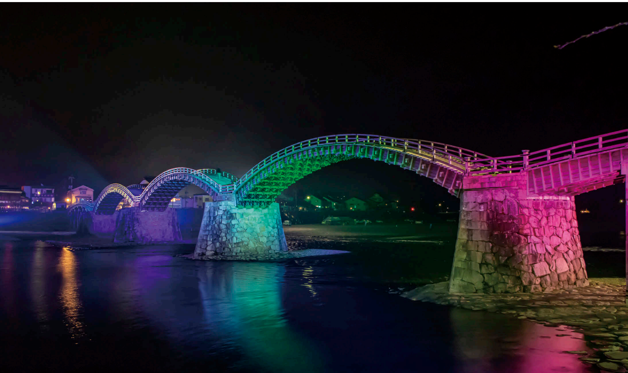
ライトアップ試験風景 3台1組のフルカラーLED投光器①②の光色を1台ごとに変えて3色固定する演出プログラムを設定。
