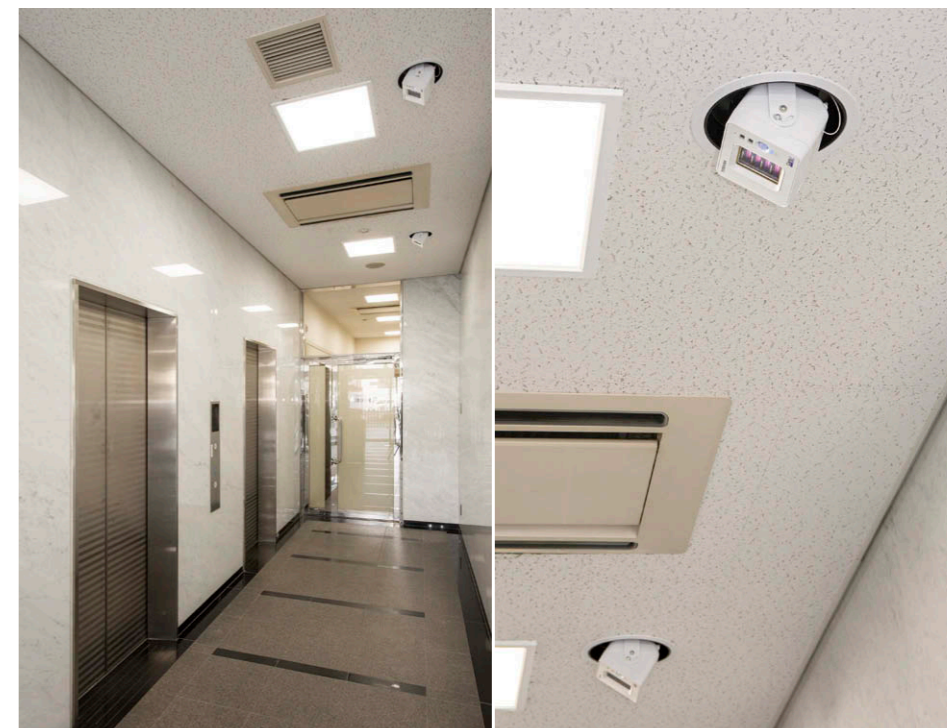
エレベーターホール 2台のエレベーターの前にそれぞれ1台ずつ Uvee ①を配置。密閉空間となるエレベーターに対する空間除菌(エアロゾル)と、人が触れる乗場押しボタンの表面除菌を実施。
