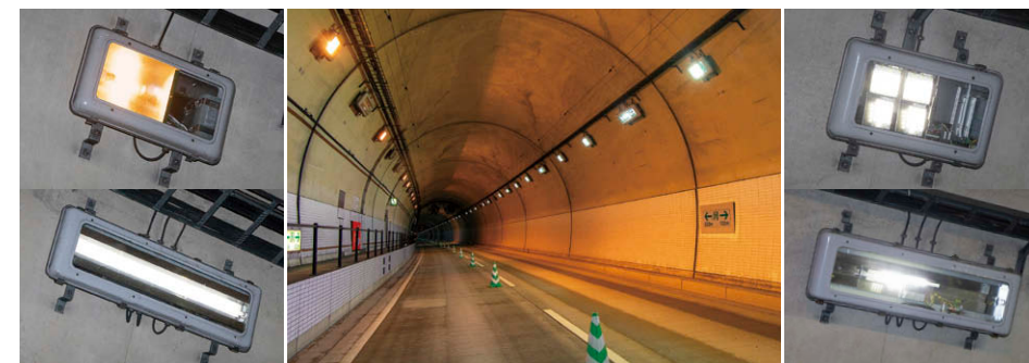
（左）既設の入口照明と基本照明。（中）施工途中の坑口付近風景。左壁側は既設、右壁側は交換済み。（右）LED化後の入口照明と基本照明。
