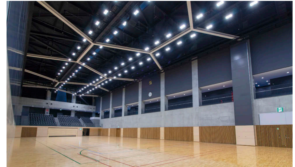
小アリーナ 可動式の間仕切り壁によって分けられた小アリーナ。T/Flecs仕様のLED高天井器具①により、小アリーナのみを使用時でも、きめ細かな照度調整が可能。
