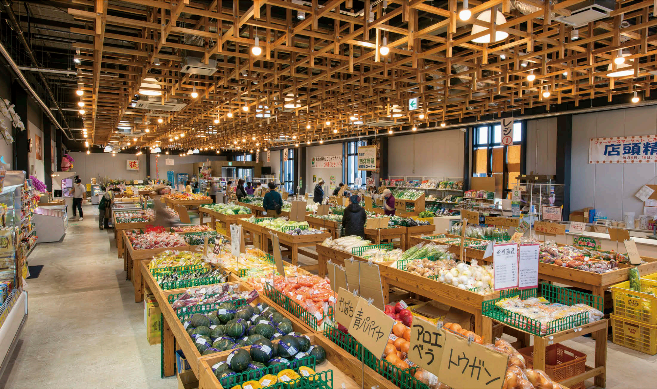
直売所（うんたま市場）の照明風景 9 系統のライティングレールを設置し、2700K の LED ペンダントライト①と 4000K の LED スポットライト②を接続。
