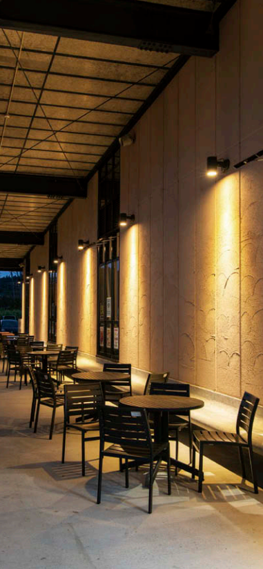
外壁の照明 3000K の LED 小形投光器④で左官仕上げの壁を照らし「土っぽさ」を強調。創り出された縦ラインにより、建物全体のスケール感も演出。
