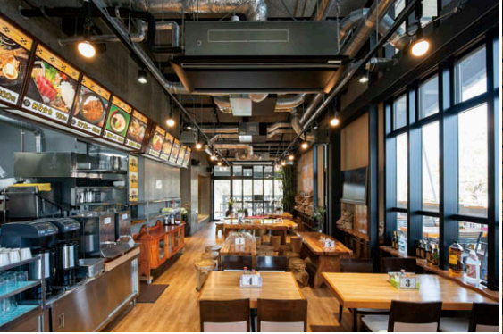
レストラン店内 スケルトン天井に大きな長方形のライティングレールを設け、LED ペンダントライト①と LED スポットライト②を配置。
