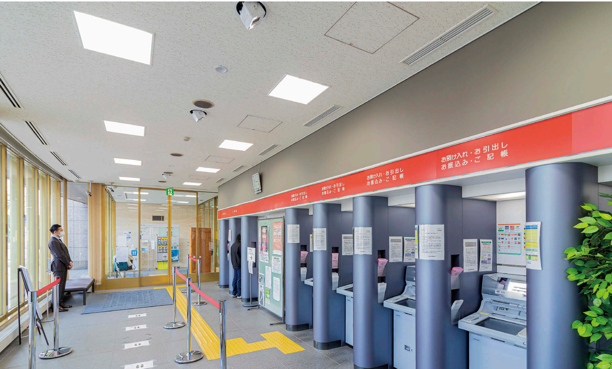
ATMおよび両替機コーナー(奥側から) 3台のUVeeユニバーサルダウンライト①を導入し、キャッシュディスペンサーのタッチパネルにUVを照射。
