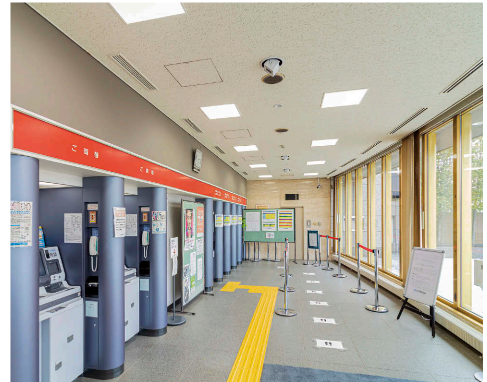
ATMおよび両替機コーナー(入口側から) 機械操作画面(タッチパネル)から3mの距離をとってUVeeユニバーサルダウンライト①を設置。40度の角度でUV照射。
