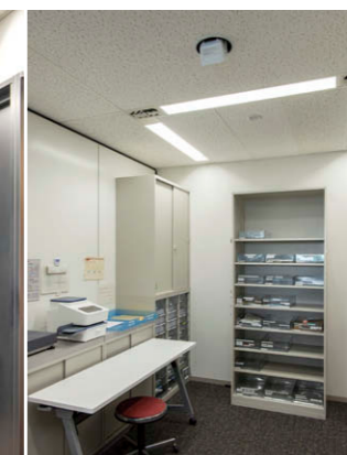
7階メールコーナーに設置した UVee①
