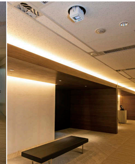
6階エントランスに設置した UVee① 2.2mの取り付け間隔を開けて2台を設置。
