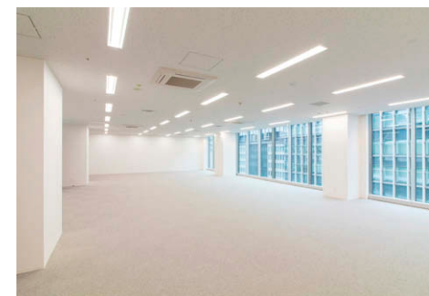
会議室 一般利用が可能な会議室は、人感センサー内蔵のLEDベースライトTENQOOシリーズ⑤を採用。
