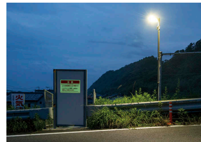
避難階段出口側照明風景 3灯のうちの1灯を避難階段出口横に設置。
