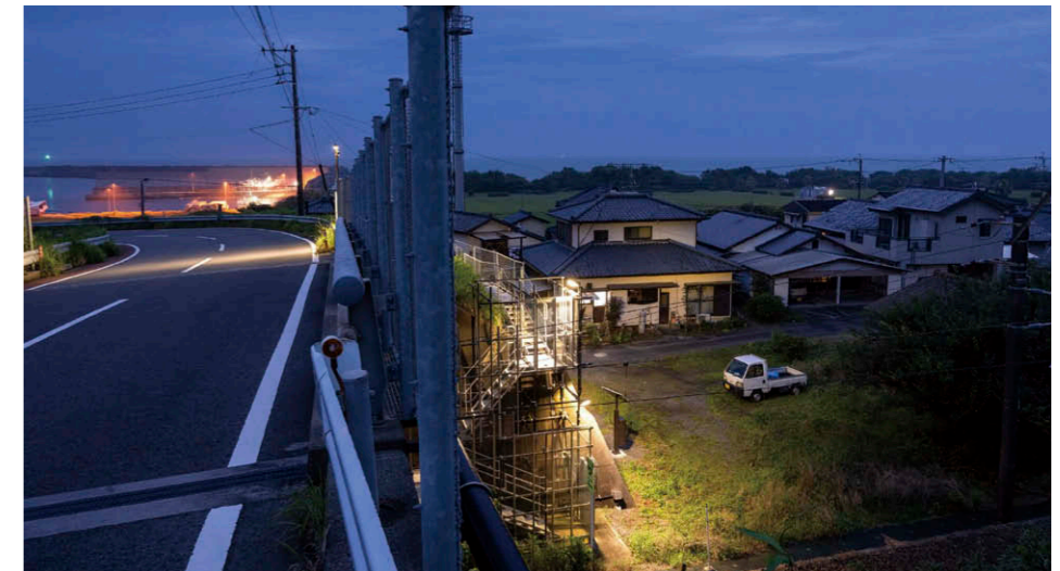
道路橋の上からの照明風景 LEDソーラーライトの避難誘導灯①が点灯した状態を橋上から望む。写真左側の道路向こうに川南港が、右側に通浜地区の住宅地が見え、その向こうに日向灘が横たわる。
