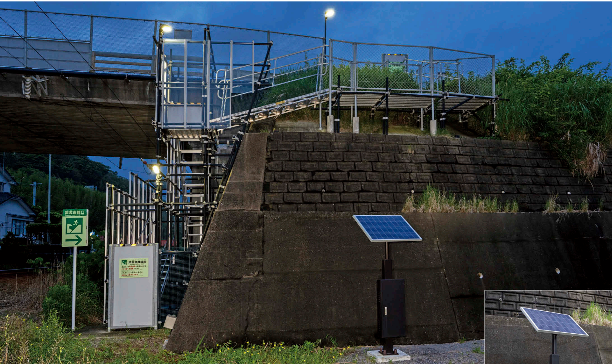
避難階段下から JR線をまたぐ道路橋の脇に避難経路を短絡する階段を設け、特注品の灯具3灯LEDソーラーライト①を設置。
