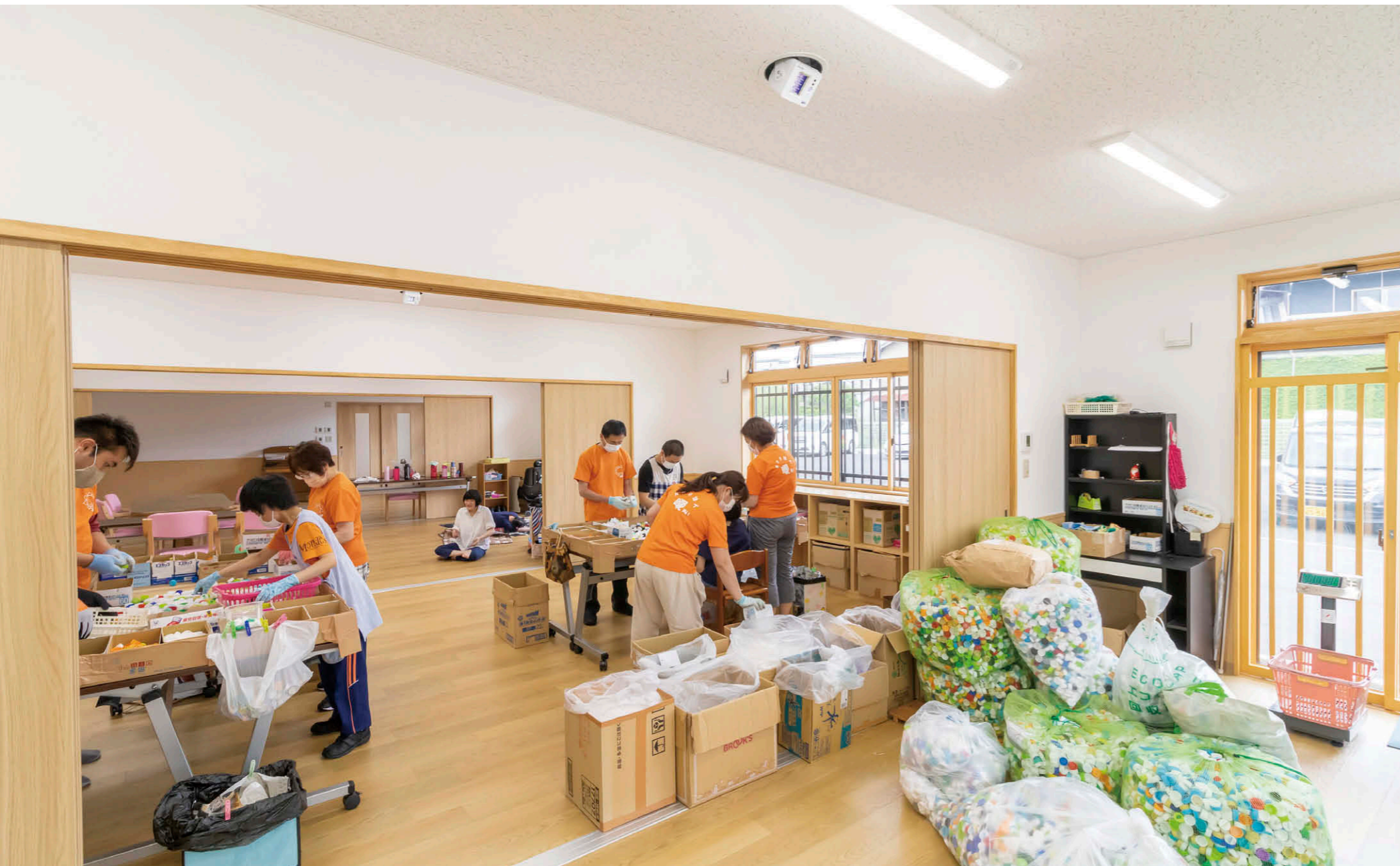
指定生活介護支援事業（un・un）の作業スペース 有人環境でも空間のウイルス抑制・除菌が行える UVec ユニバーサルダウンライト①を計4台設置。
