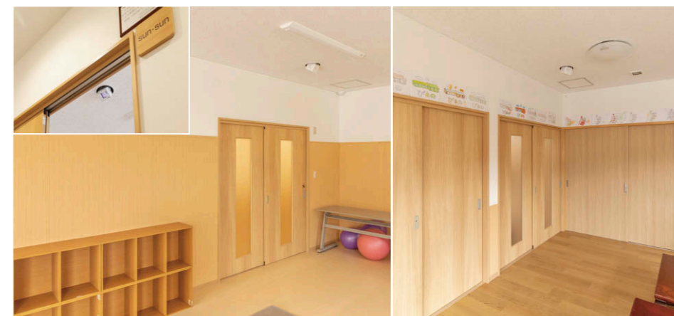
（左）日中一時支援事業（sun・sun）、（右）児童発達支援・放課後等デイサービス（fun）部屋の入口天井部に UVec ユニバーサルダウンライト①を設置して引手部を照射。
