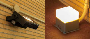
(上) サブエントランスの LED 照明⑦⑧ (左下) LED 小形投光器⑦ (右下) LED 門柱灯⑧
