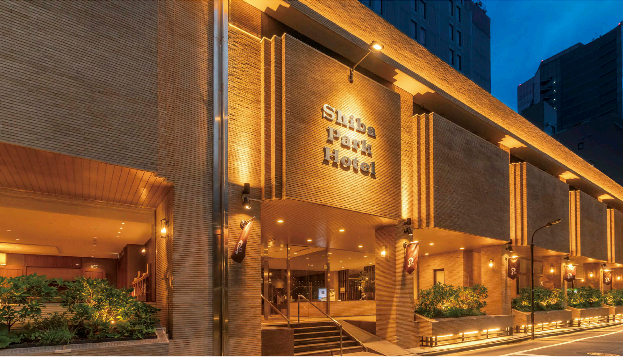
正面エントランス周辺から建物右奥への外壁ライトアップ①②
