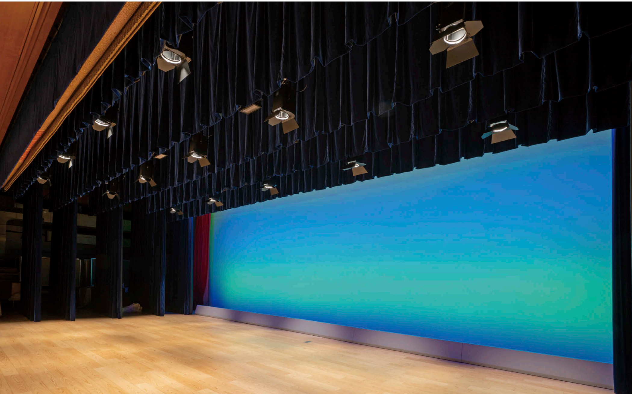
フルカラーLED水平ライトによる多彩な調色 上部にフルカラーのLEDアッパー水平ライトを、床部にはLEDロー水平ライトを配置②③④⑤。
