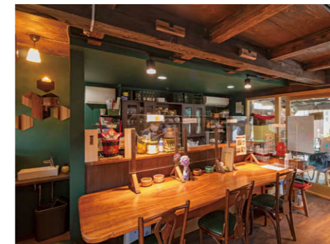
古民家カフェ ライティングレールとLED一体形スポットライト④により座席位置の変化にも柔軟に対応。
