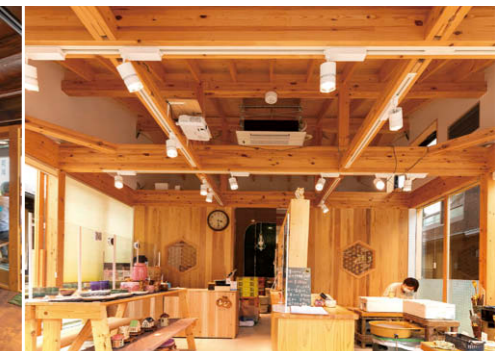
陶芸工房 新築棟では白塗装のライティングレールとLED一体形スポットライト⑤を採用。
