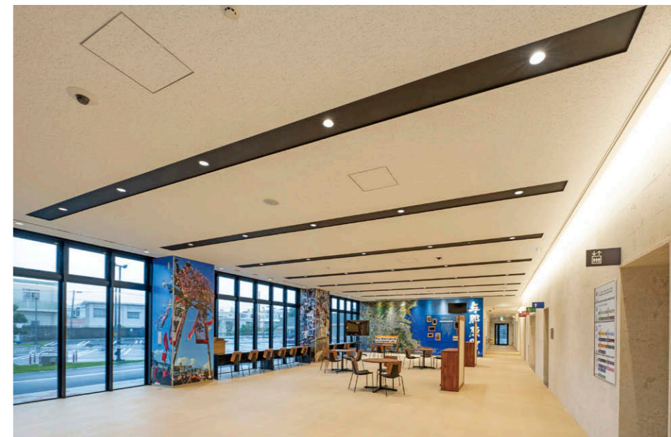
1階町民ラウンジ 入口から見たLEDユニバーサルダウンライト②とLEDライン器具③による照明。
