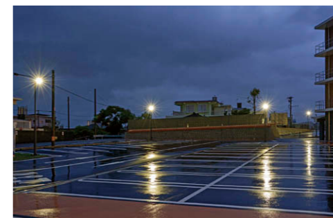
駐車場 LED小形投光器⑤による照明。
