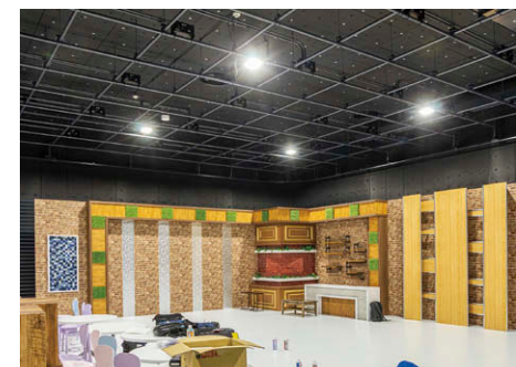
第2スタジオ は照明グリッドとコンセントボックスを敷設。照明器具は旧スタジオより移設。
