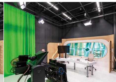
報道スタジオ 独立した制御系としグリッドにLEDブロードライト③、LED スポットライト④を配置。
