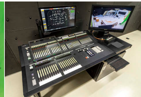
調光操作卓⑤ RDM 双方向通信を備え1台でメインスタジオ、第2スタジオ、多目的ホールの制御が可能。
