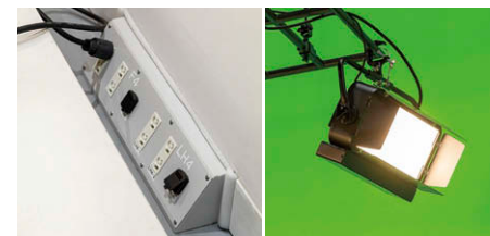
フロアトレンチ内のコンセントボックス LEDブロードライト(電球色相当)①
