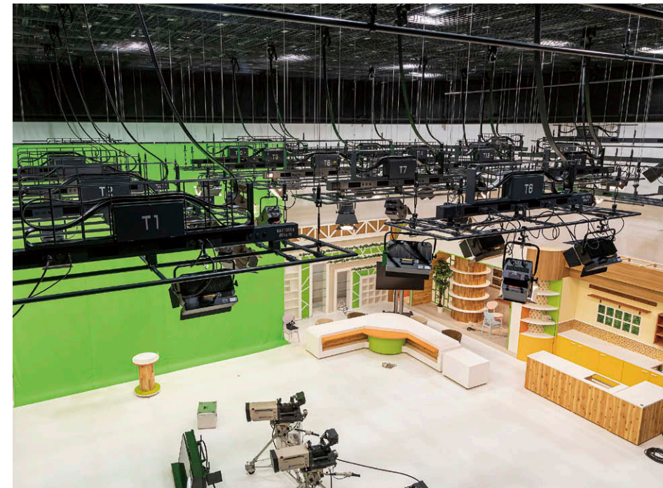
メインスタジオ (階段踊り場から望む) 小型・軽量のスマートラスバトンに、LED ブロードライト①、LED スポットライト②を配置し、セットへの干渉が少なく自由度の高いライティング環境を実現。
