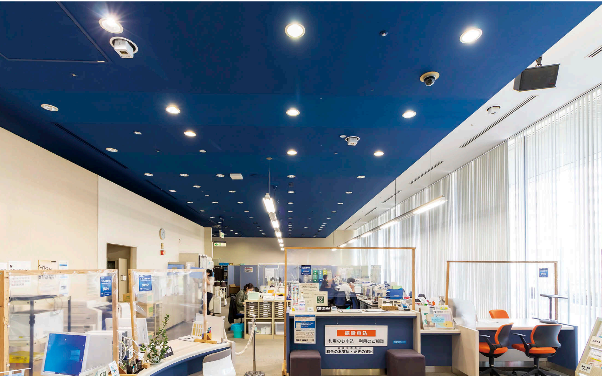
受付カウンター 3つのカウンターに照射するため3台のUVec ①を設置。
