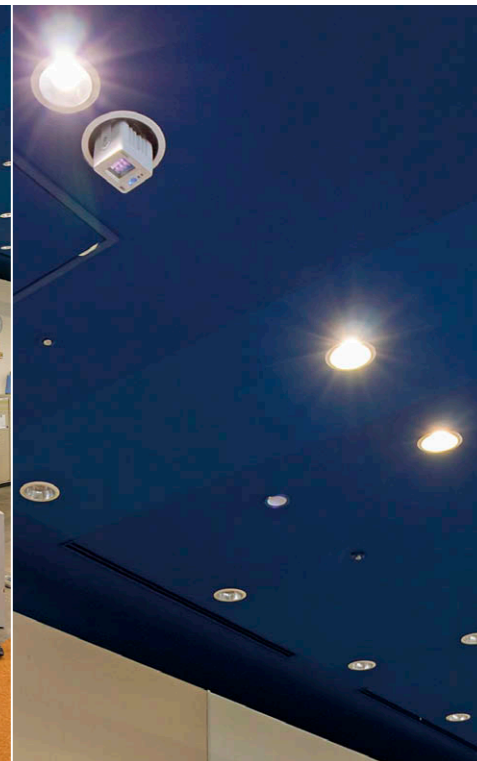
すべてのUVec ①は カウンターに鉛直方向に光源を設定。
