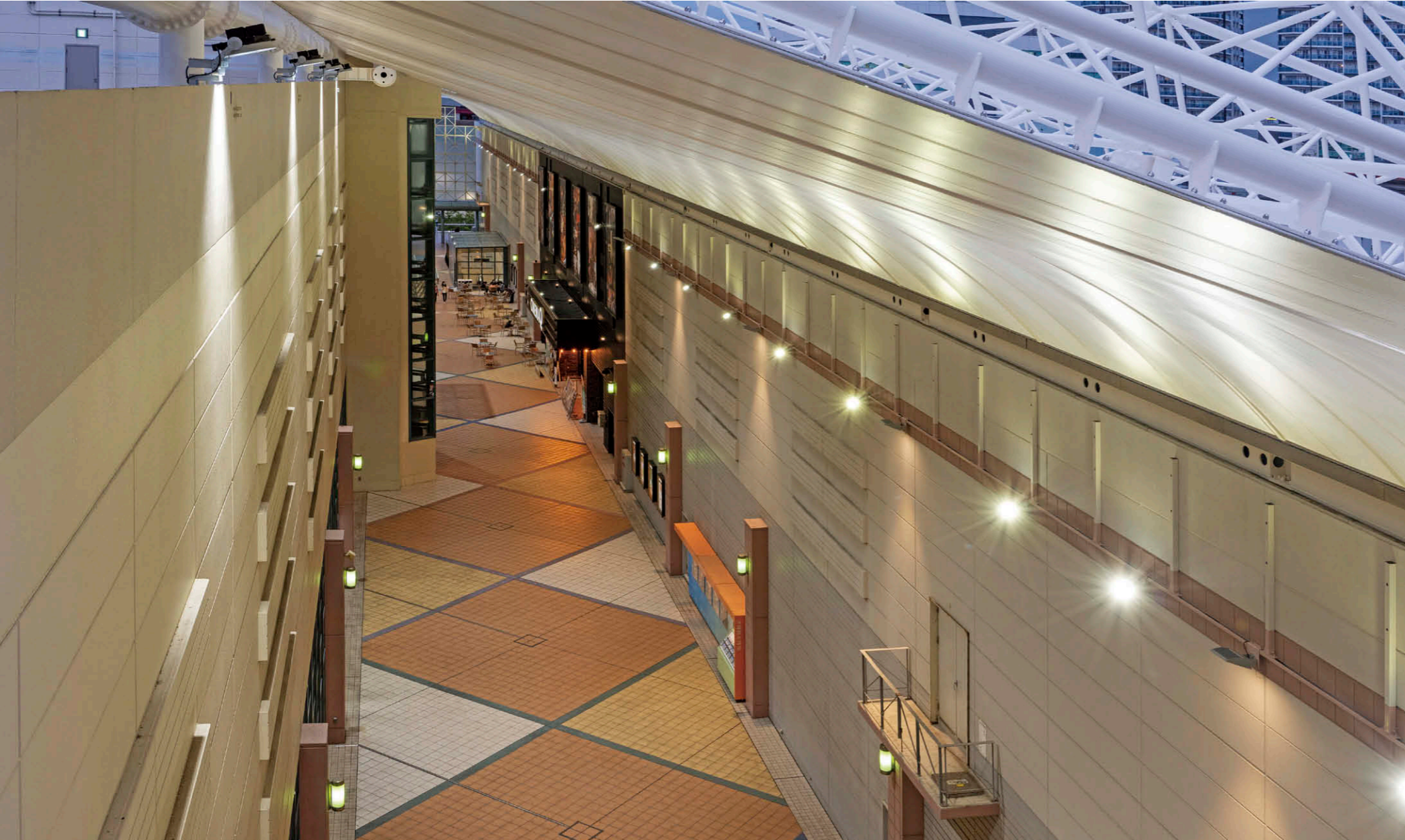
オープンモール全景（西口上部より） 店舗側（左側）には昼白色の LED 投光器①を下向きに、シネマ壁面（右側）は電球色の LED 小形投光器②を下向きに、昼光色の LED 小形投光器横長タイプ③を上向きに設置。
