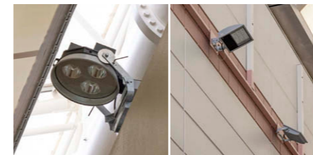
(左) 店舗側 LED 投光器① (右) シネマ側 LED 小形投光器②③
