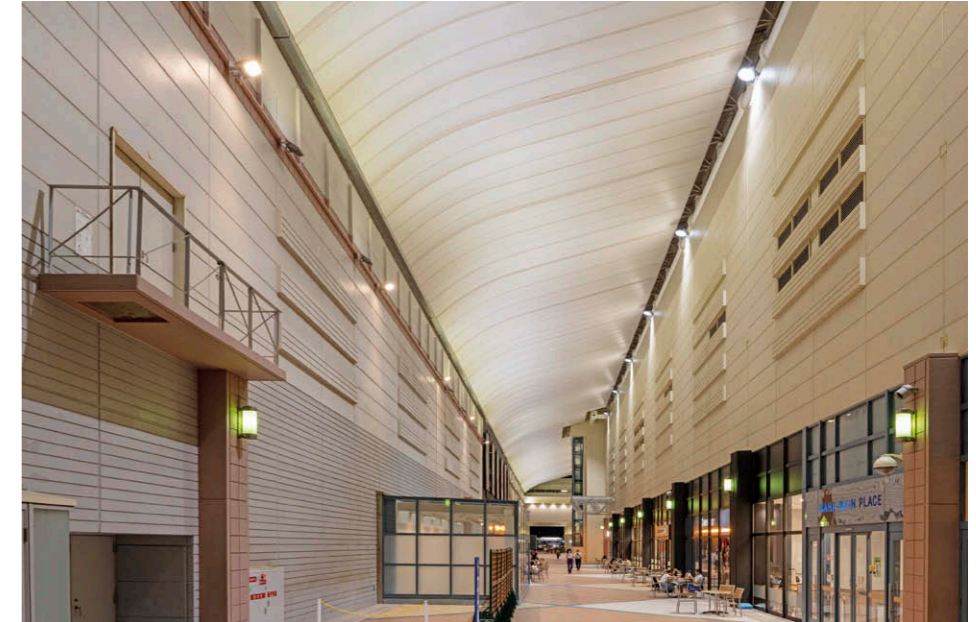
東口からの照明風景 シネマ側（左側）に電球色の LED 小形投光器②を採用し、落ち着いた雰囲気のリラックスできる空間を演出。
