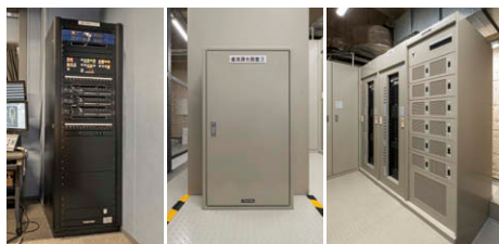
(左)調光制御ラック (中)直流調光器盤⑦ (右)主幹盤・調光器盤⑥
