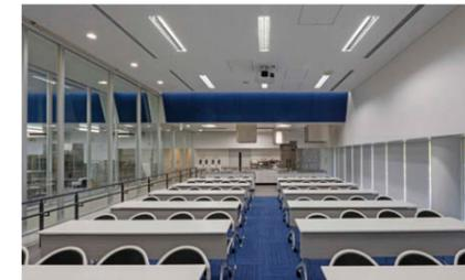
会議室兼調理実習室の照明 ベースにTENQOOシリーズシステムユニットOAアルミルーバー器具⑤、窓側通路部に人感センサー付LEDユニット交換形ダウンライト⑥、キッチン上にLEDベースライトスクエア光源ユニット形⑦を配置。
